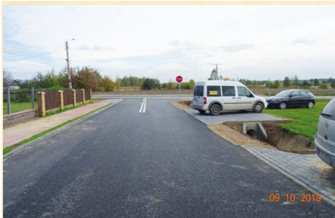
z Funduszu Dróg Samorządowych w łącznej kwocie: 1.185.888 zł. Przebudowa drogi dojazdowej do pól uprawnych w Grzybowej Górze na działce nr 14 - etap II objęła wykonanie odcinka dł. 95,00 m, podbudowy z kruszywa łamanego, pobocza z zamknięciem
