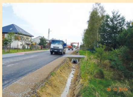
z Funduszu Dróg Samorządowych w łącznej kwocie: 1.185.888 zł. Przebudowa drogi dojazdowej do pól uprawnych w Grzybowej Górze na działce nr 14 - etap II objęła wykonanie odcinka dł. 95,00 m, podbudowy z kruszywa łamanego, pobocza z zamknięciem
